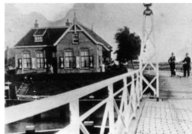
De draaibrug met brugwachtershuis in 1914. (Hannemahuis Harlingen)
