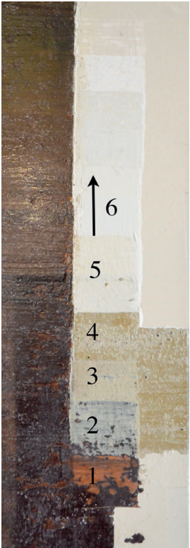
Detail van 26a, met stratigrafie en rechts een klein kleurvenster van de afwerkfase van Telting. Bovenop de donkerbruine afwerking van Westerhuis (1) zit de uitmonstering die kort na 1834 onder Telting tot stand kwam (2-4). De donkergele kleur van deze afwerking zal door vergeling en verdonkering van het olie- en/of vernishoudende bindmiddel zijn ontstaan. De stratigrafie toont de afwerkklagen met lithopoomwit uit 1895 (5) en latere steeds wittige uitmonsteringen (6). De afwerking van Westerhuis is zeer sleets doordat deze is geschuurd toen men de uitmonstering onder Telting aanbracht. Om de leesbaarheid hiervan te vergroten is het kleurvenster geretoucheerd. Foto's: From Isolation to Coherence
