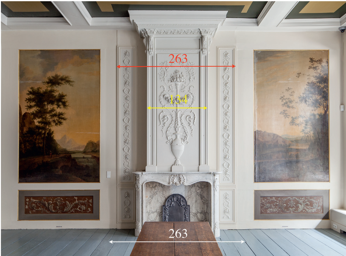
30. Westwand van de geschilderde kamer met breedte huidige schouwboezem (gele pijl); afstand tussen de houten betimmering aan weerszijden van de schouw (rode pijl), dit geeft de maat van de onder Westerhuis geplaatste schouw aan; breedte van de onder Westerhuis ingebrachtte bodemplaat (witte pijl). Foto: From Isolation to Coherence
