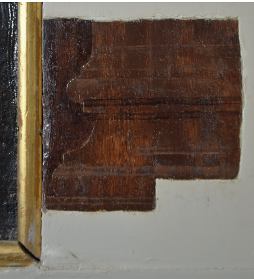
8b. Kleurvenster van een trompe-l'oeil basement waarop de geschilderde pilasters rusten (oostwand rechts). Links langs de contour is de kraslijn zichtbaar waarmee de vormen waren aangegeven. Foto: From Isolation to Coherence
