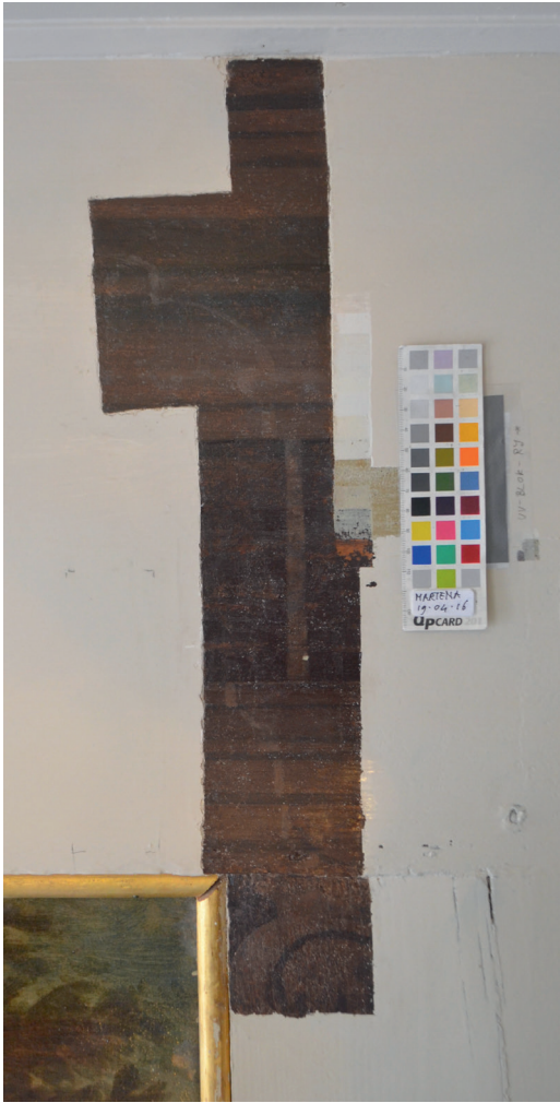
26a,b. Stratigrafie op de oostwand boven de toegangsdeur met links een groot geretoucheerd kleurvenster van de donkerbruine architectuurafwer-king uit de tijd van Westerhuis
