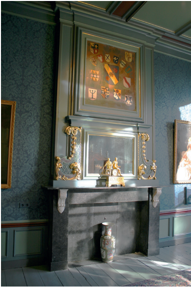
32. De schouw in de achterzaal van het Martenahuis bestaat uit een onder Westerhuis ingebrachte platte houten boezem in Daniel Marot-stijl en een strakke zwarte empire schouwmantel met witmarmeren consoles die kort na 1834 zal zijn ingebracht. De voorzijde en bovenrand van de mantel zijn van marmer en de zijkanten van geschilderd hout. De schouwboezem en lambrisering zijn tegenwoordig geschilderd in kleuren die geïnspireerd zijn op het kleurschema van Westerhuis zoals dat is aangetroffen bij het kleuronderzoek in 2005, Office for Architectural Paint Research & Conservation. Foto: From Isolation to Coherence
