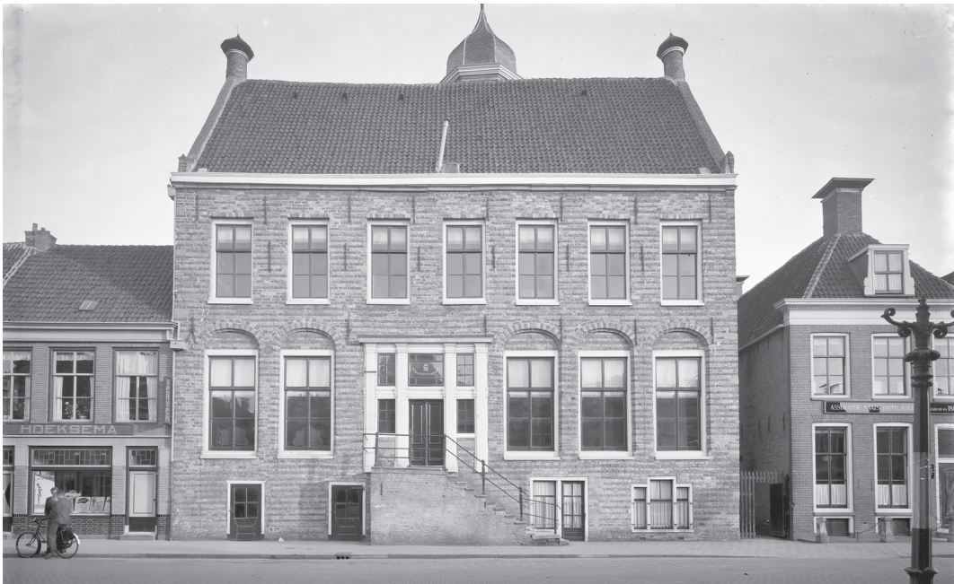
24. Voorgevel van het Martenahuis, 1946. De onder Telting aangebrachte zesruitschuifvensters zijn nog aanwezig. Ook heeft het bordes nog een enkele trap. Foto: Rijksdienst voor het Cultureel Erfgoed
