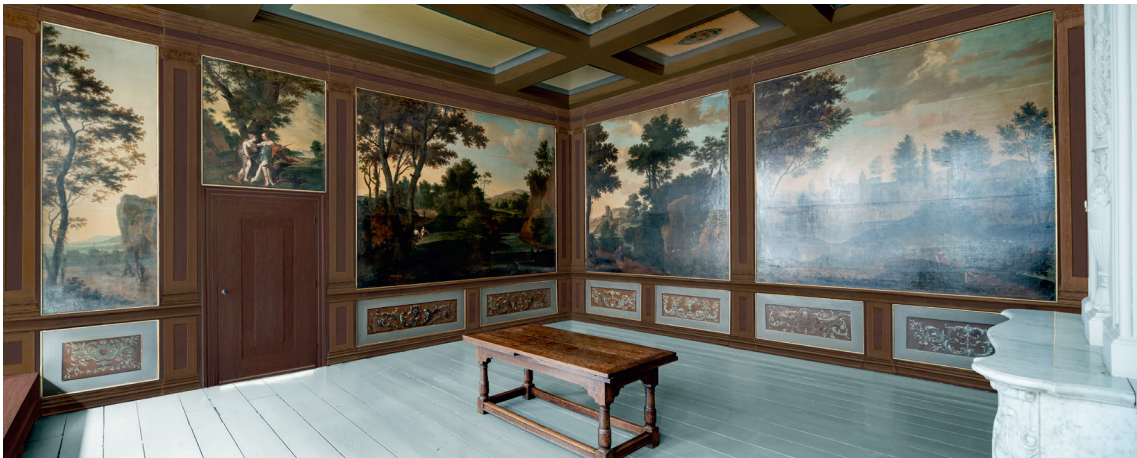
8c. Digitale impressie van de trompe-l'oeil schildering. De impressie is gebaseerd op kleurvensters van het houtwerk in de balk langs het plafond ter hoogte van het rechter landschap op de oostwand (egale schildering zonder differentiatie); boven het bovendeurstuk (gekorniste kroonlijst); tussen het bovendeurstuk en landschap rechts (bovenzijde pilaster met Ionisch kapiteel); rechts naast het rechterlandschap op de oostwand (basement pilaster); boven het rechter lambriseringsdoek op de westwand (buijkljst); boven en rechts naast het rechter lambriseringsdoek op de oostwand (buijkljst en paneelwerk); de plint links van het rechter lambriseringsdoek op de westwand (geprofileerde voet en plint). Bij de impressie is ervan uitgegaan dat de schildering zich herhaalt op overeenkomstige locaties en zijn lijnen van de schildering doorgetrokken om de verschillende elementen met elkaar te verbinden. In de digitale impressie is alleen de schildering op de betimmering opgenomen, de overige elementen in het interieur, zoals de vloer, schouw en aanpassingen in de doeken zijn niet meegenomen. Foto: Rijksdienst voor het Cultureel Erfgoed. Digitale bewerking: L. de Moor
