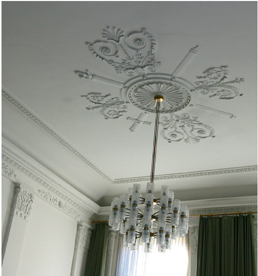
28. Interieur kantongerecht Sneek, bouwjaar 1839. Foto: From Isolation to Coherence
