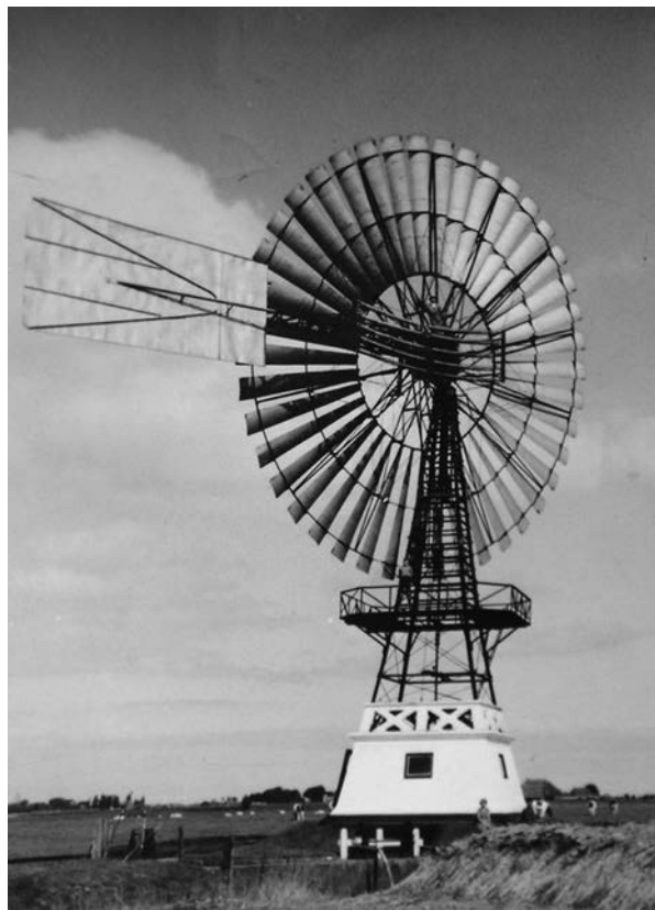
> De 'reus van de Kloosterpolder' werd bij Slappeterp omstreeks 1913 opgericht. De windmotor was 16 meter hoog en had een raddiameter van 15 meter. (Tresoar)
