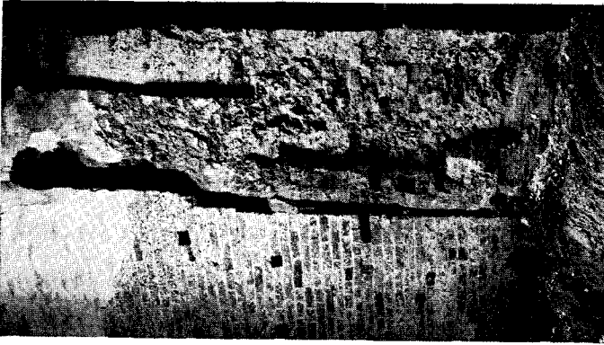
23. Aansluiting van transept bij oude zijbeuk voor restauratie.
