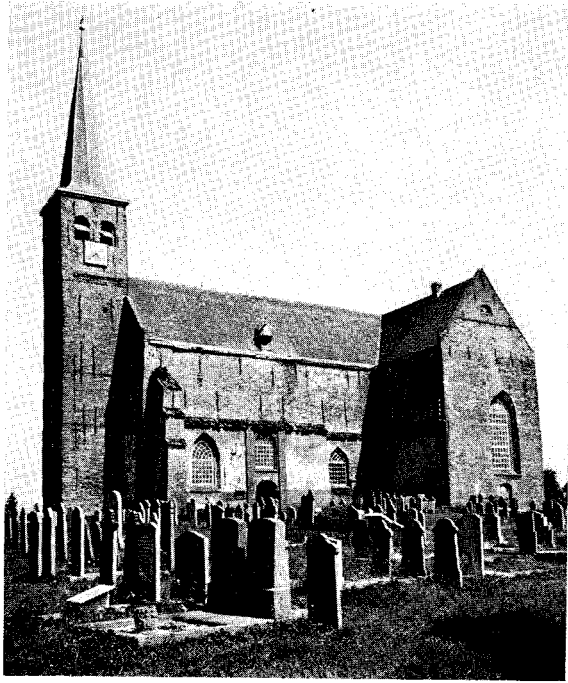
27. Zuidgevel voor restauratie.
