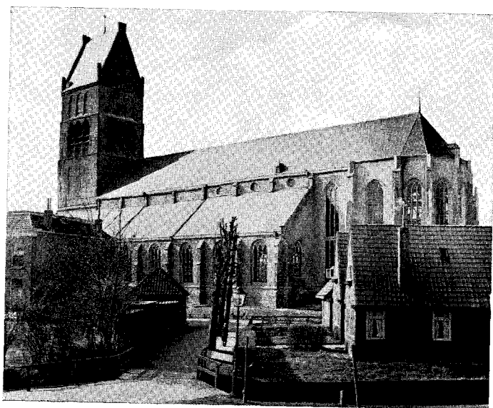
2. Kerk te Bolsward na restauratie.
