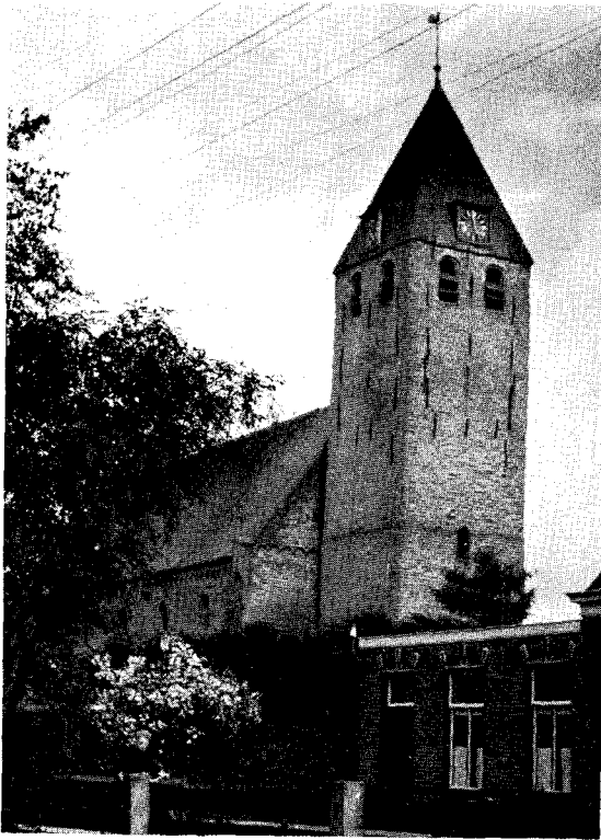
5. Kerk te Oudega (Sm.) na restauratie.
