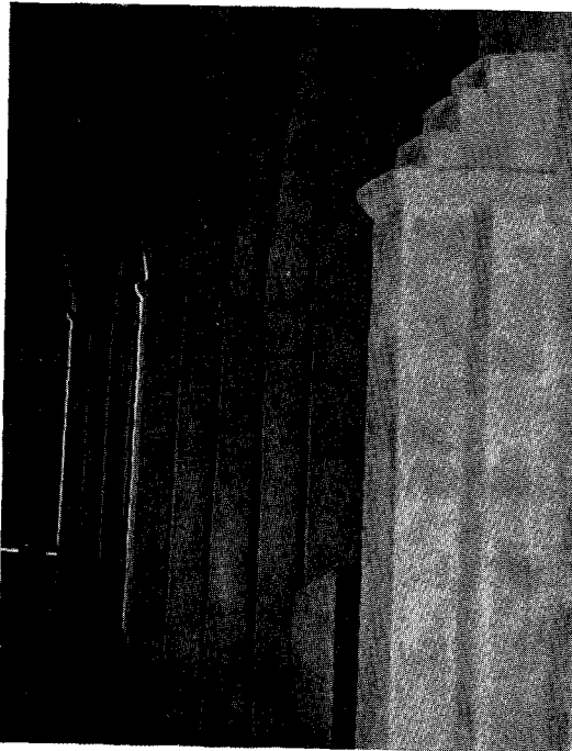
26. Toegevoegde zijbeuk na restauratie.
