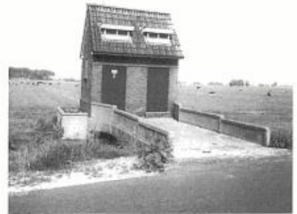
Trafohuisje te Munnekeburen
