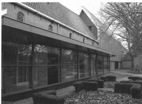
Aanbouw Museum het Hannemahuis
