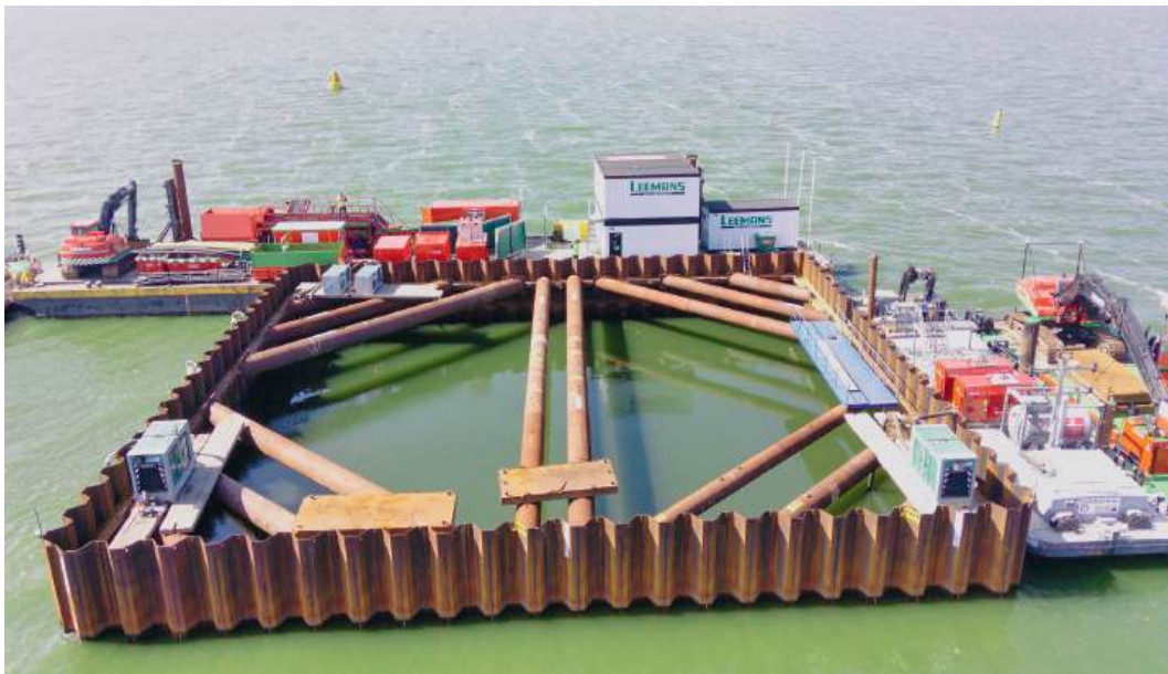
8. De damwandput in het IJsselmeer ten behoeve van de berging van het vliegtuig. Foto: gemeente Súdwest-Fryslân
