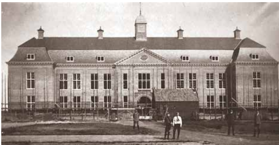
De bouw van de Rijks HBS aan de Torenstraat in Drachten, 1918.
